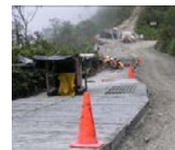
Jalan Industri PTFI di MP 55
