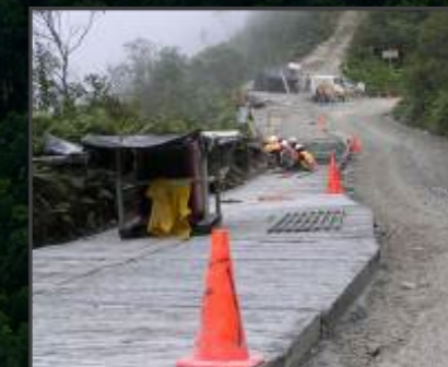
Jalan Industri PTFI di MP 55
