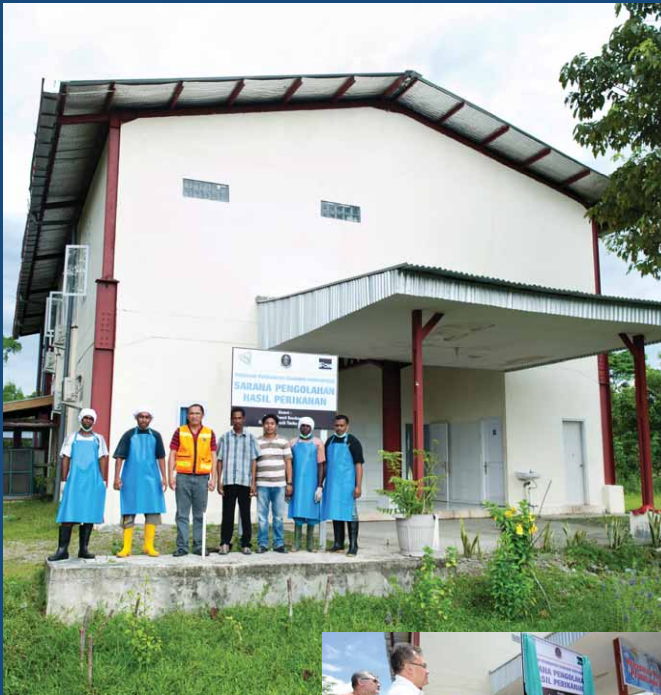
Fasilitas pengolahan ikan
